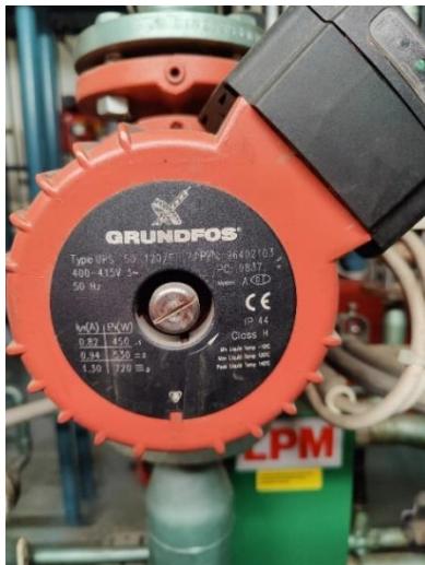
Lämmityksen kiertopumppu.
