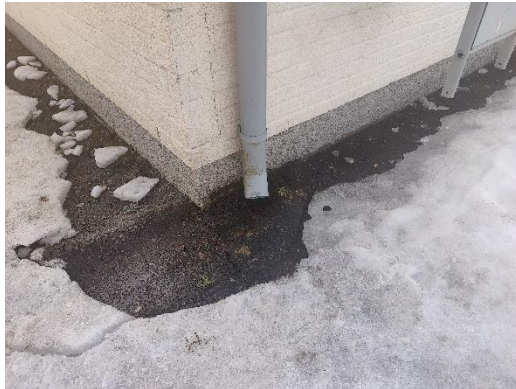
Puuttuva rännikaivo.
