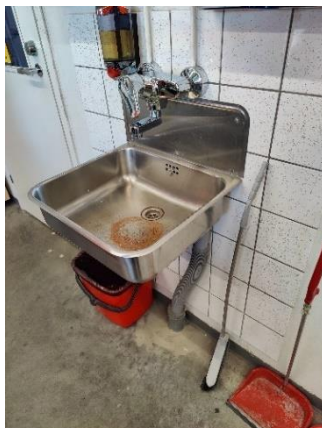
Metallityö luokan hanan virtaamat olivat yli suositellun. Mitattu virtaama oli 20...25 l/min .
