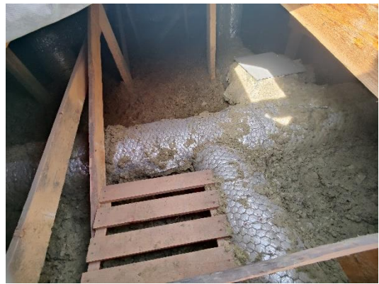
Yläpohjatilaa päästiin tarkastelemaan lähinnä tarkastusluukkujen ympäristöstä.
