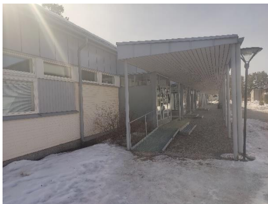
Sisäänkäyntikatokas normaalissa kunnossa.
