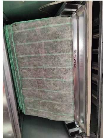
IV-koneiden suodattimet olivat tarkastushetkellä likaiset.
