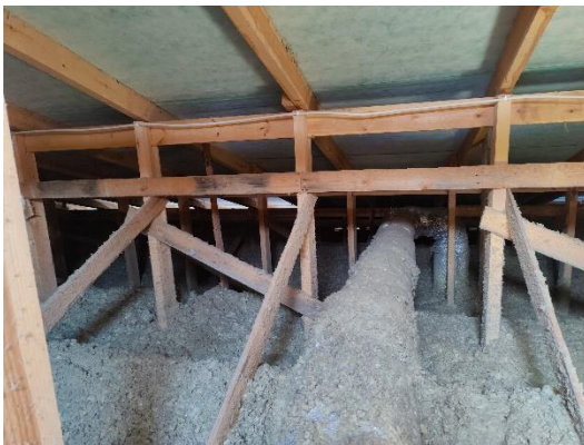
Yläpohjatilaa päästiin tarkastelemaan lähinnä tarkastusluukkujen ympäristöstä.
