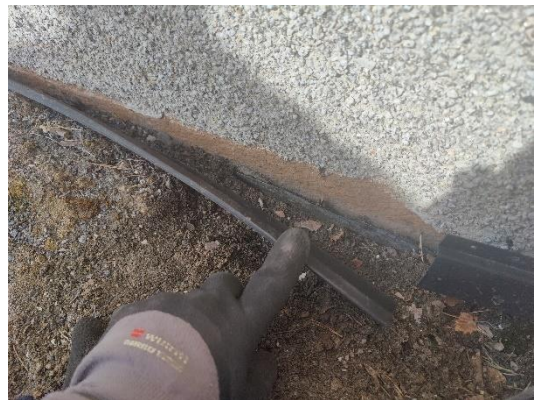
Osa patolevyjen yläreunalistoista ei ole tiiviitä.
