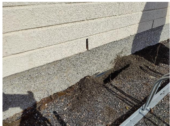
Sokkelia vasten piha-alueen kivituhka.
