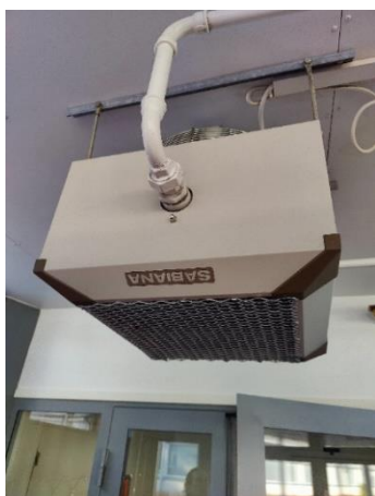
Tuulikaapin kiertoilmalämmitin.
