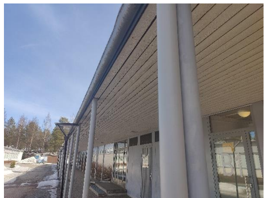
Sisäänkäyntikatokas normaalissa kunnossa.
