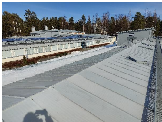
Vesikatolla ei merkittäviä puutteita.
