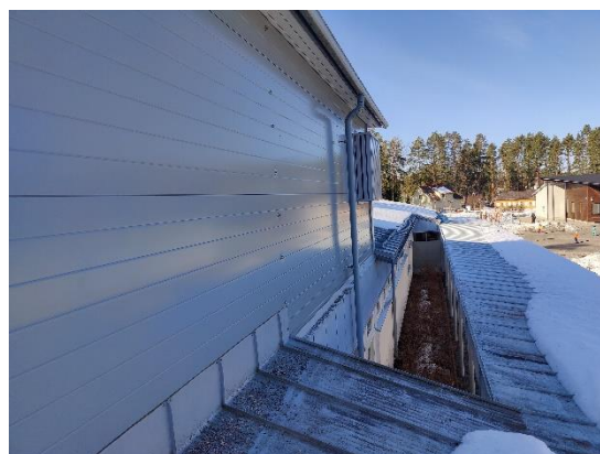
Uusitun IV-konehuoneen seinät pelti-villa-pelti-elementtejä.
