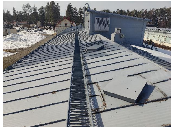
Kulkusilloissa ei puutteita.
