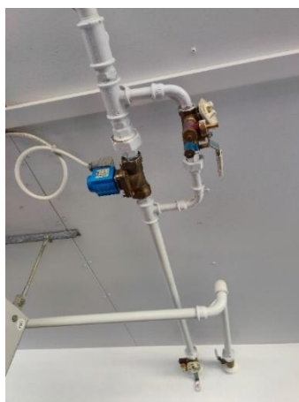
Kiertoilmalämmittimen kytkentä.
