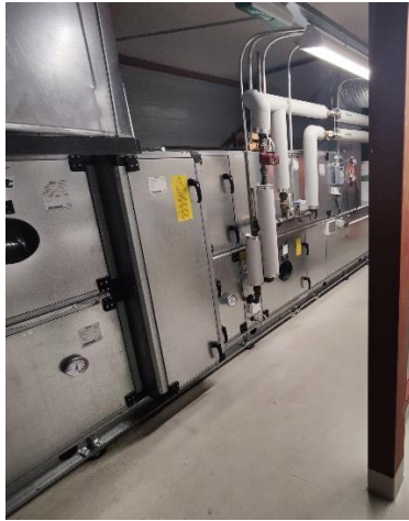
IV-koneet ovat moduulirakenteisia.
