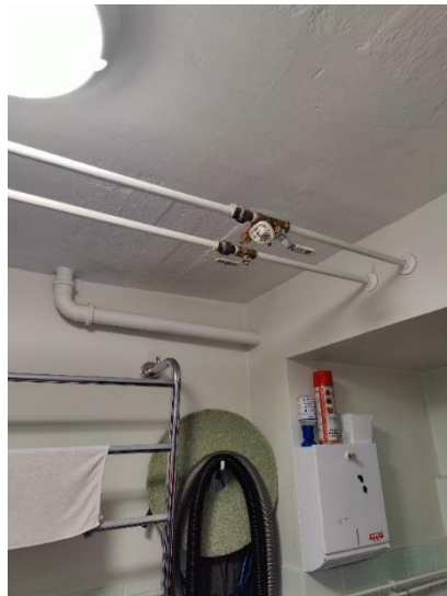
Linjasäätö- ja sulkuventtiilit.
