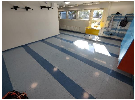
Käytävällä 163 havaittiin lievää kosteuspoikkeamaa. Syy ei selvinnyt.
