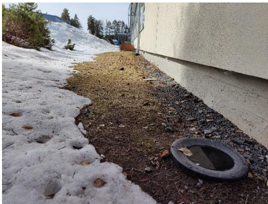
Havainto ainoastaan yhdestä salaojan tarkastuskaivosta.
