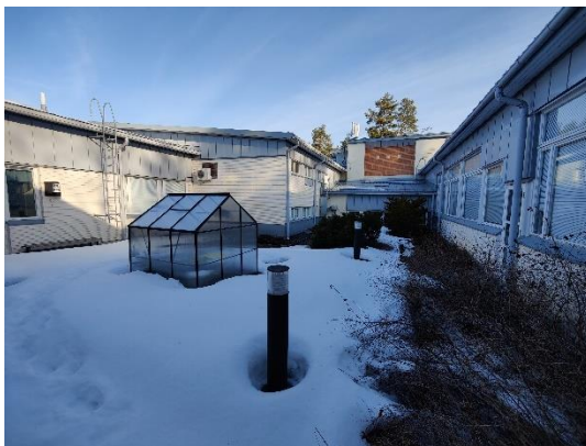
Sisäpihalla istutuksia liian lähellä sokkeleita.
