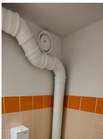
WC-tilan poistoilmaventtiili.
