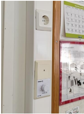
Pistorasia ja äänentoistojärjestelmän ohjauskäytin hyvässä kunnossa.
