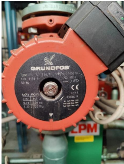
Lämmityksen kiertopumppu.
