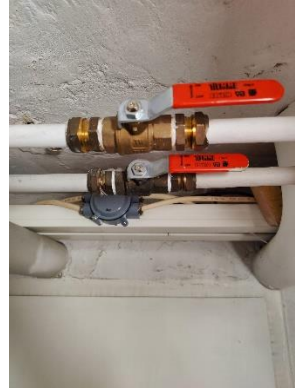
Käyttövesijohtojen sulkuventtiileitä
