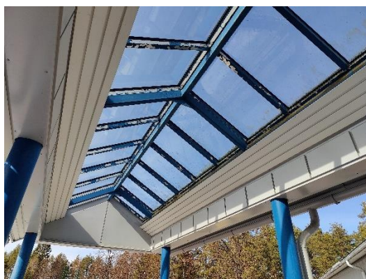
Katosten rakenteet normaalissa kunnossa.
