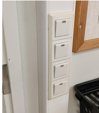
Kytkimet päällisin puolin hyvässä kunnossa. On/Off-valaistuksen ohjaus.
