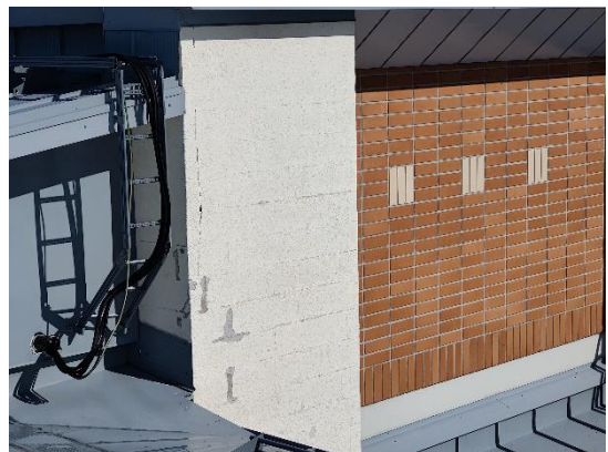
Palloilusalin seinillä alkavaa maalipinnan hilseilyä.
