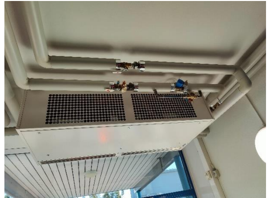
Oviverhopuhaltimen kytkentä.
