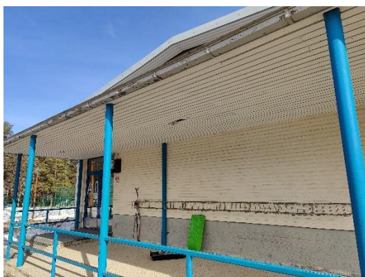
Katosten rakenteet normaalissa kunnossa.
