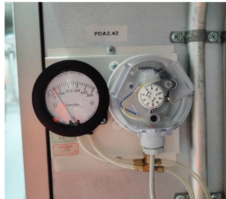
IV-koneiden suodattimet olivat tarkastushetkellä puhtaat.
