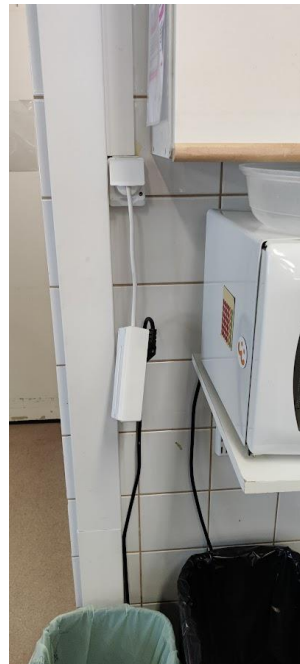
Valmistuskeittiössä erinäisiä jatkoroikkavirityksiä.
