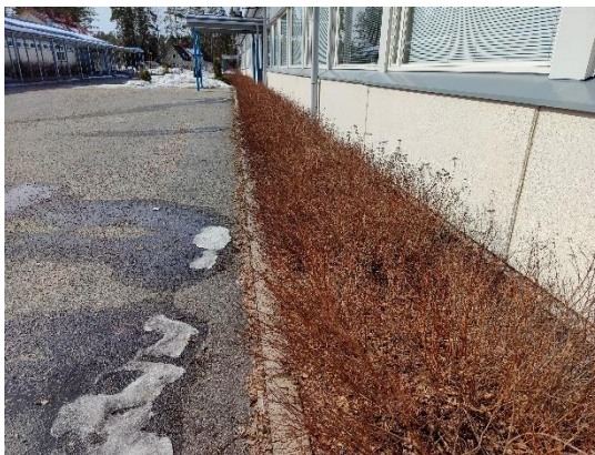
Istutuksia liian lähellä sokkeleita.
