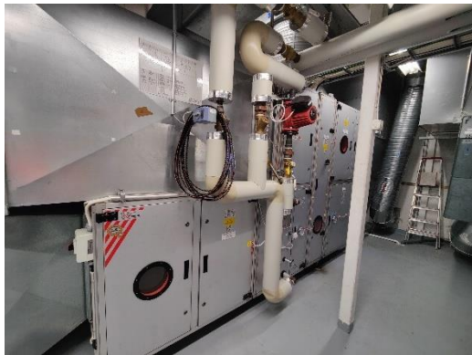
IV-koneet ovat moduulirakenteisia.
