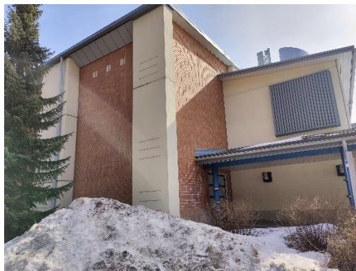
Palloilusalin ulkoseinät elementtirakenteisia.
