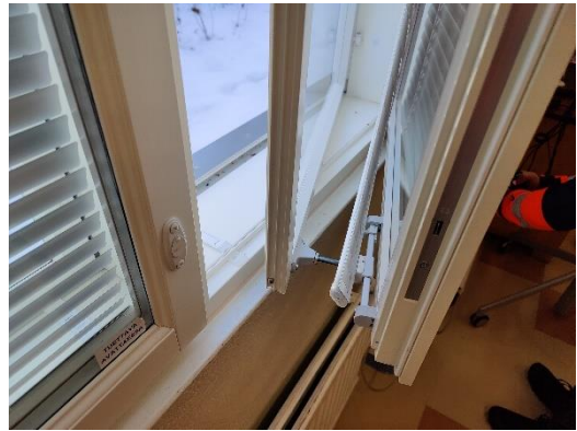
Osa ikkunoista uusittu umpiolaselementilliseksi. Myös umpiolaselementillisiä ikkunoita eri-ikäisiä.
