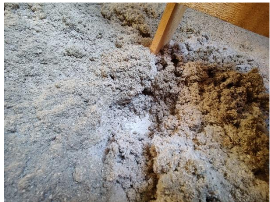
Eristekerros paikoin alamittainen.
