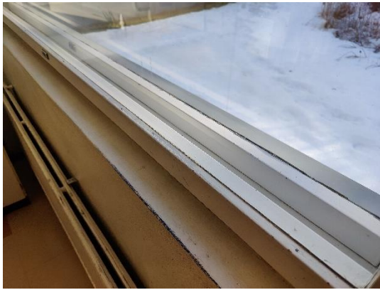
Vanhat ikkunat 2-lasisia ikkunoita.
