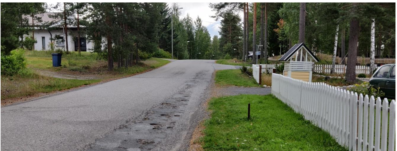
Kuva 7: Oikealla Mäntytien liittymä, vasemmalla Helluntaiseurakunnan rakennus. Tiessä on näkyvä haittava harjanne (Kuva: J. Silvennoinen 2022).
