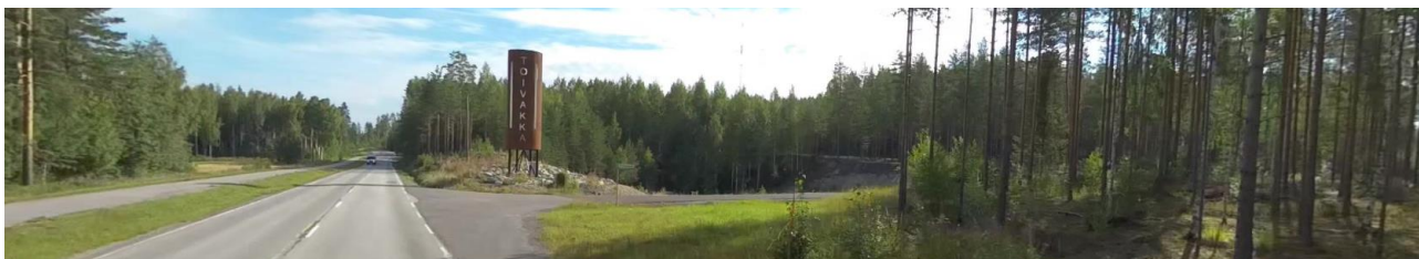
Kuva 10: Rakennelman vieressä oleva vanha soranottokuoppa on Heittokankaantien rakentamisen myötä tullut näkyviin aiempaa selvemmin. Alueen rakentuminen parantaisi maisemaa tältä osin selvästi.
